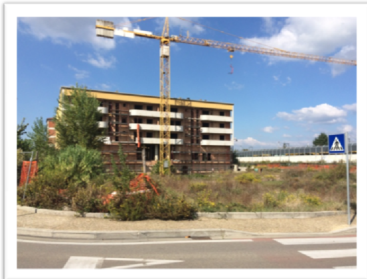
Cantiere abbandonato – via Petrarca, Figline e Incisa Valdarno
