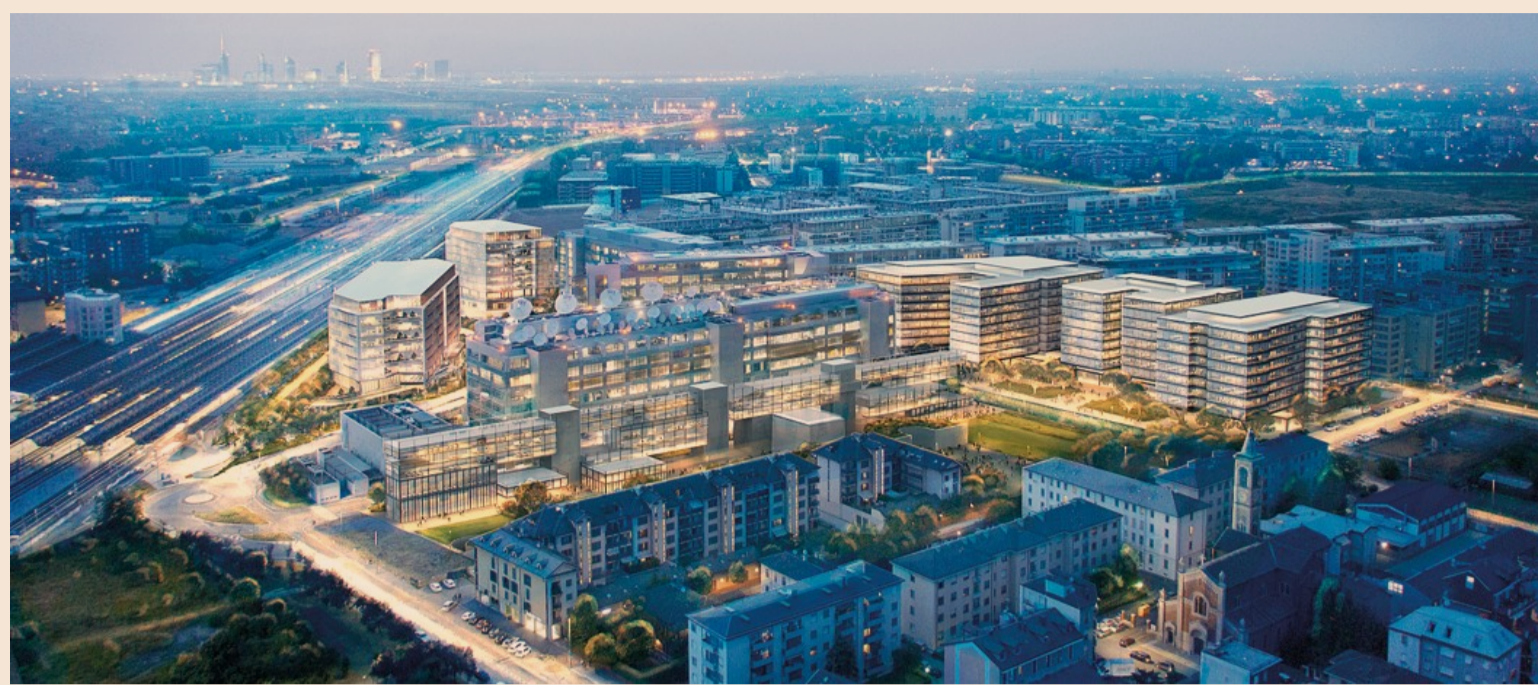
In fase di realizzazione. Il rendering del nuovo business district in fase di costruzione attorno alle torri di Sky a Milano Santa Giulia
