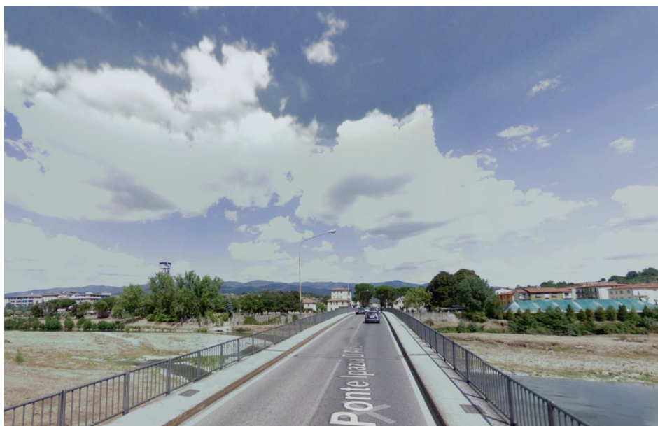
Figura 48 – Ponte Ipazia – stato attuale
